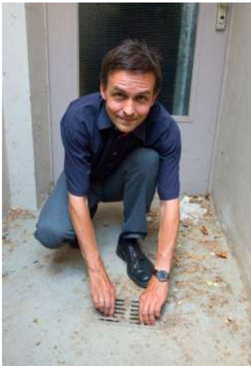
Wer sich für ein gebrauchtes Haus interessiert, der muss auch auf Details achten, etwa den Ablauf vor der Kelleraußentür: Wohin führt eigentlich die Entwässerung? Wie steht es mit der Gefahr des Rückstaus? Wo liegen die entsprechenden Rückstauklappen und sind sie intakt? Wurden die Abläufe regelmäßig gewartet und gereinigt – Wartungsarbeiten, zu denen Sachverständige dringend raten.
