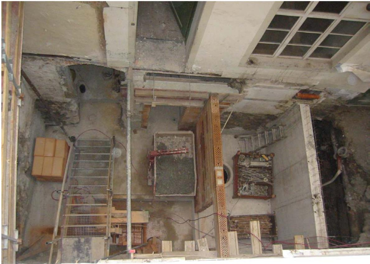
Sanierung eines barocken Hauses am Markplatz in Lindau (2): Um das barocke Gebäude und seine teilweise erheblich älteren Nebengebäude zusammenhängend modern nutzen zu können, wurde das gesamte Untergeschoss unterfangen und um anderthalb Meter tiefer gelegt. Der Blick von oben ins entkernte Gebäude offenbart den technischen Aufwand der Sanierung.
